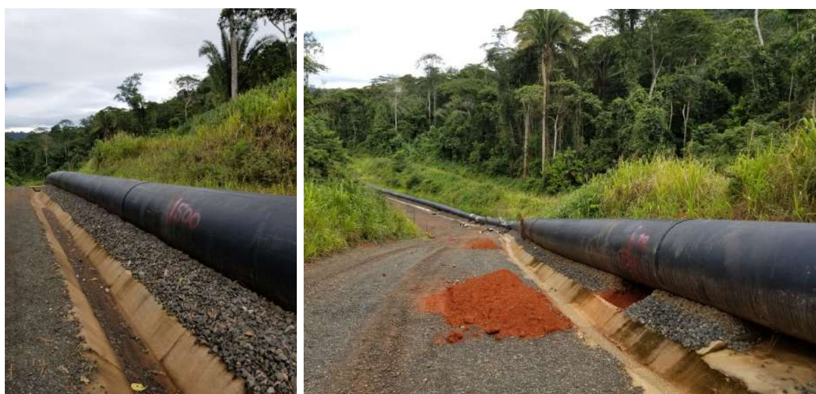
Figura 1 – Tubulação de rejeitos da Usina de Salobo
