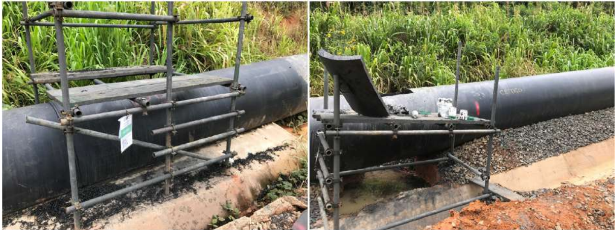
Figura 6 – Abertura de janelas de visita.
