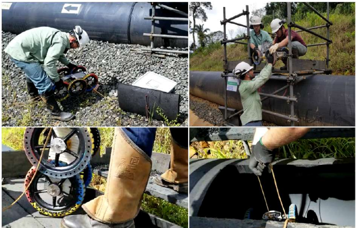
Figura 9 – Etapas de inserção do robô na tubulação.
