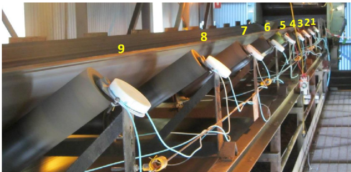
Figura 3 – Inspeção de correias utilizando fibra óptica.
