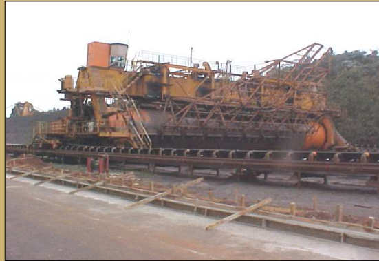
Recuperadora Tambor (Drum)
