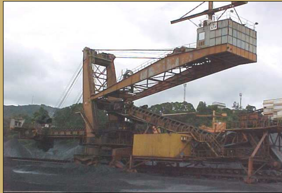
Recuperadora (Bucket Wheel)
