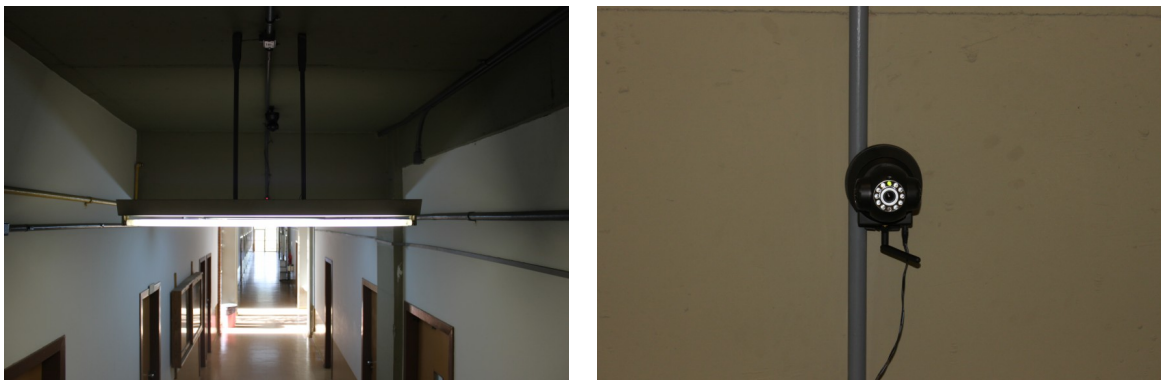
Figura 5.6: Posicionamento da câmera no corredor do DECOM/ICEB - UFOP.
